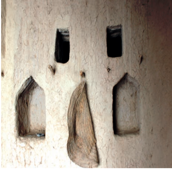
لوحة رقم (٣٤) تبين «الوتد» كحامل بجدران إحدى دور منح بسلطنة عُمان
