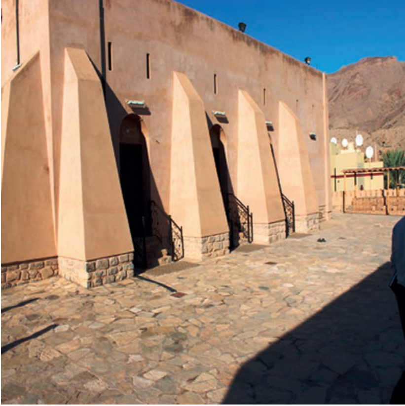
لوحة رقم (١٦) تبين «الرفادة» التي تدعم الجدران الخارجية لمسجد سعال
